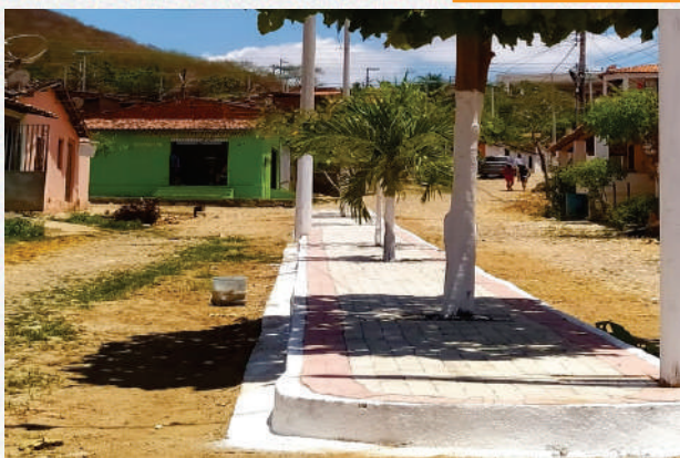
Alameda Maria Nogueira, foi construída em setembro de 2022, como um espaço de convivência e socialização.
